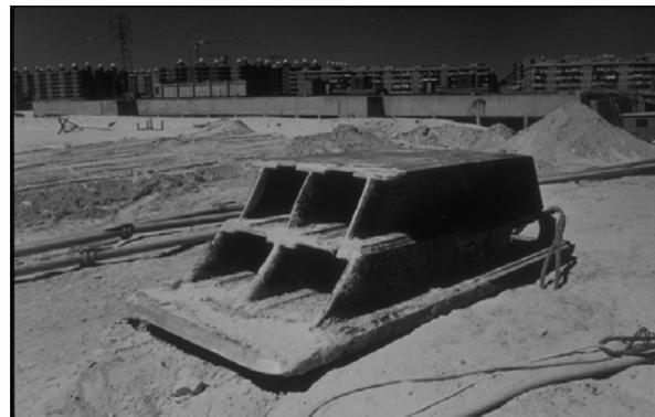
Bild 2-9: Spezialmeissel: - Meissel im Vordergrund zur Primärlamellenfugenreinigung
