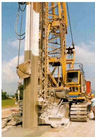
Bild 2-2: Trägergerät beim Einrütteln der Rüttelbohle [2]
