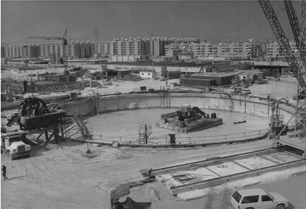
Bild 6-3: Übersicht Baugrubenaushub mittels Dredgerpumpe; abgehängt an Seilbagger und Hydraulikbagger auf Ponton zum Lösen von verbackenen Sandschichten
