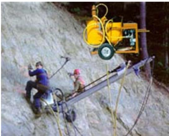
Bild 4-3: Druckluft-Bohrhammer auf Lafette geführt
