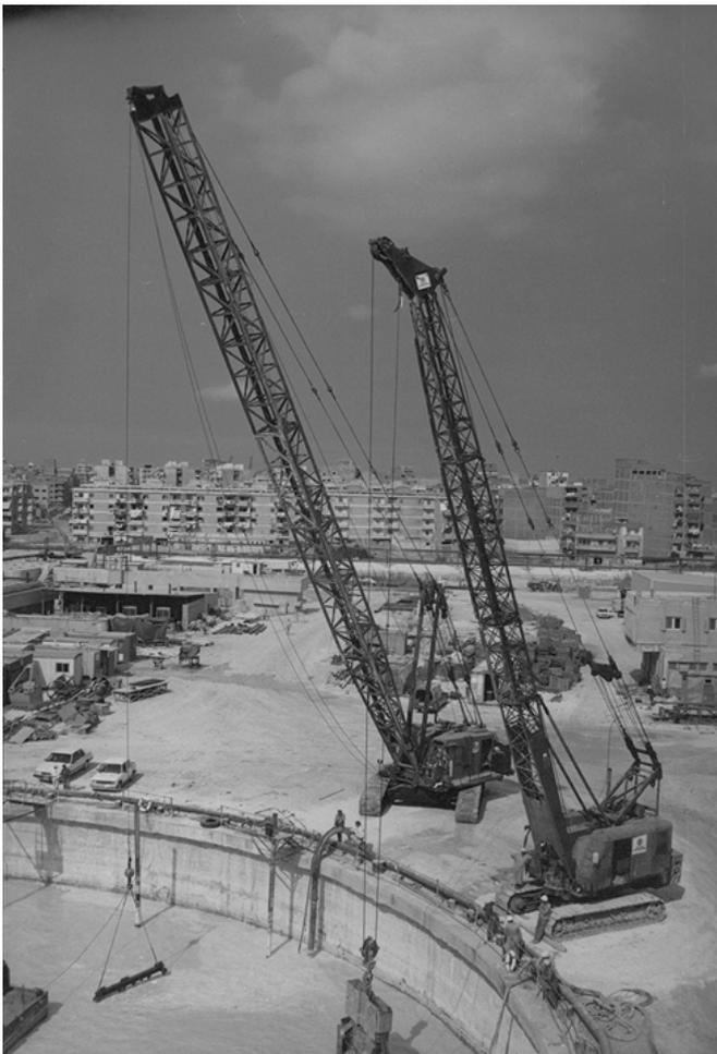
Bild 6-6: Seilbagger mit an Traversen abgehängten Dredgerpumpen
