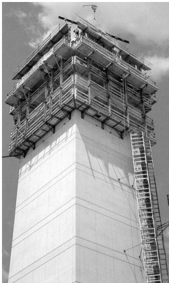
Bild 88: Selbstkletternde Schalung [82]
