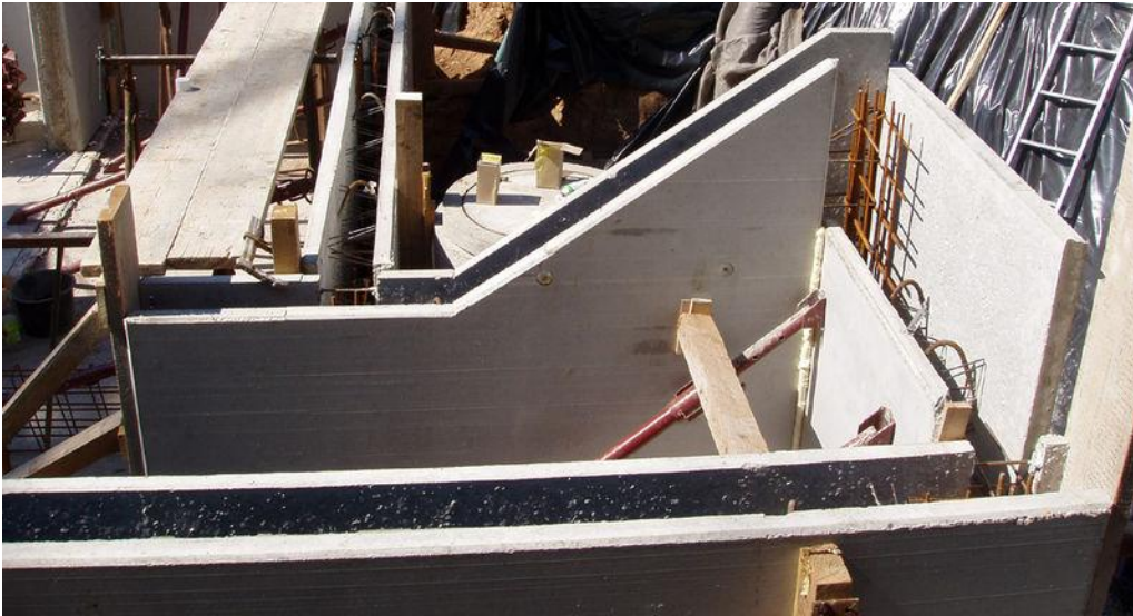
Bild 15: Hohl- oder Doppelwände mit Ortbetonausfüllung [48]
