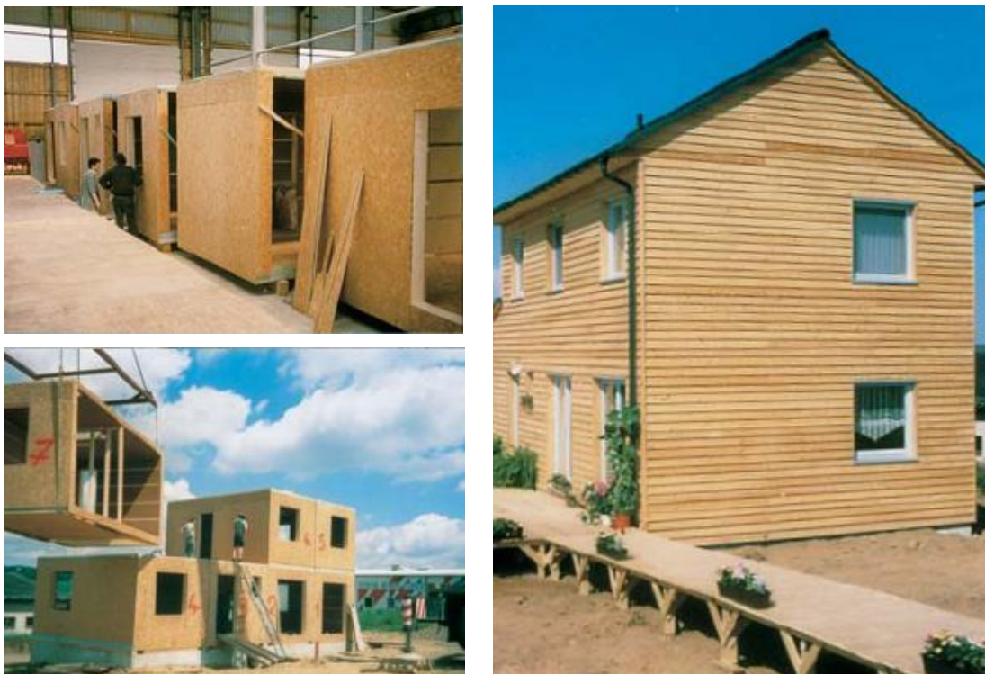
Bild 70: In Raumzellenbauweise errichtetes Gebäude [71]
