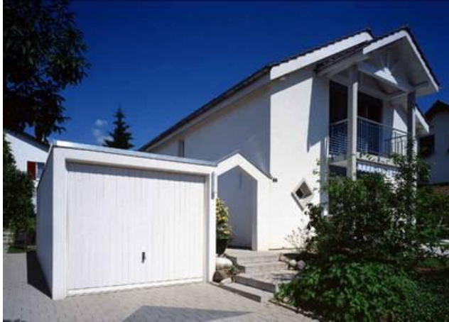
Bild 22: Fertigteilgarage als Anbau an bestehendes Gebäude [45]
