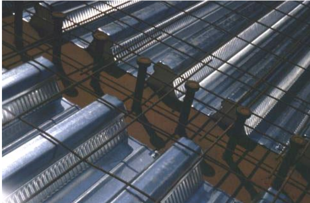
Bild 14: Stahlprofilblech-Verbunddecke [50] Die Kopfbolzendübel sind auf dem Unterzug (Verbundträger) aufgeschweisst.
