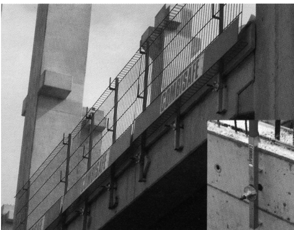
Bild 84: Montagehilfen für Absturzsicherungen im Fertigteilbau [66]
