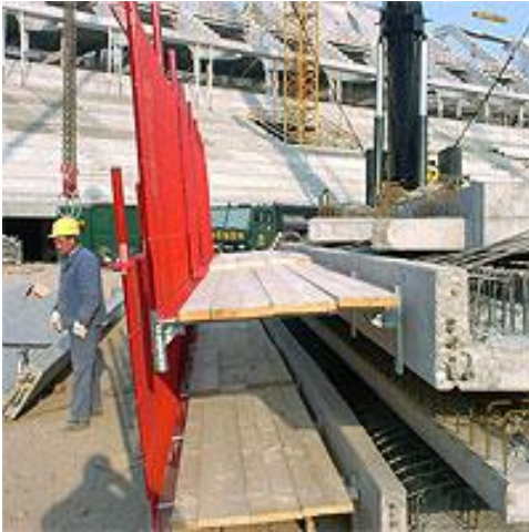
Bild 83: Absturzsicherung im Fertigteilbau [65]
