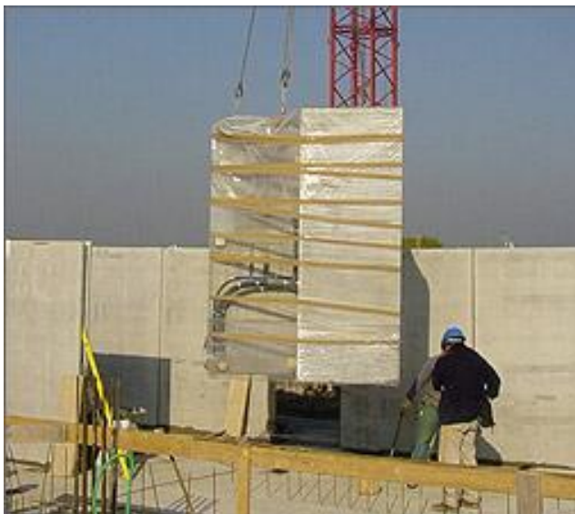
Bild 21: Kompaktes Fertigbad beim Einbau und Raumzelle von innen [44]
