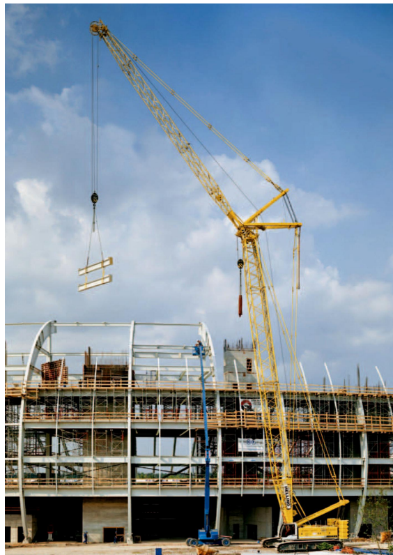
Bild 80: Montage mit einem Mobilkran [60]
