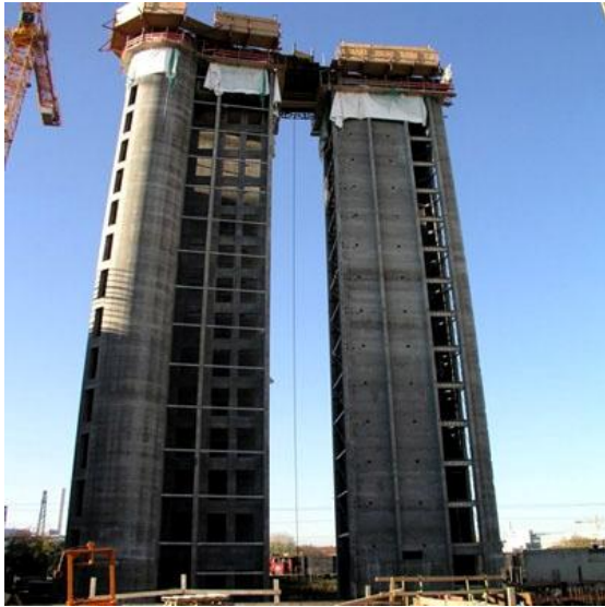
Bild 87: Im Gleitschalungsverfahren errichtete Treppen/Aufzugskerne [49]
