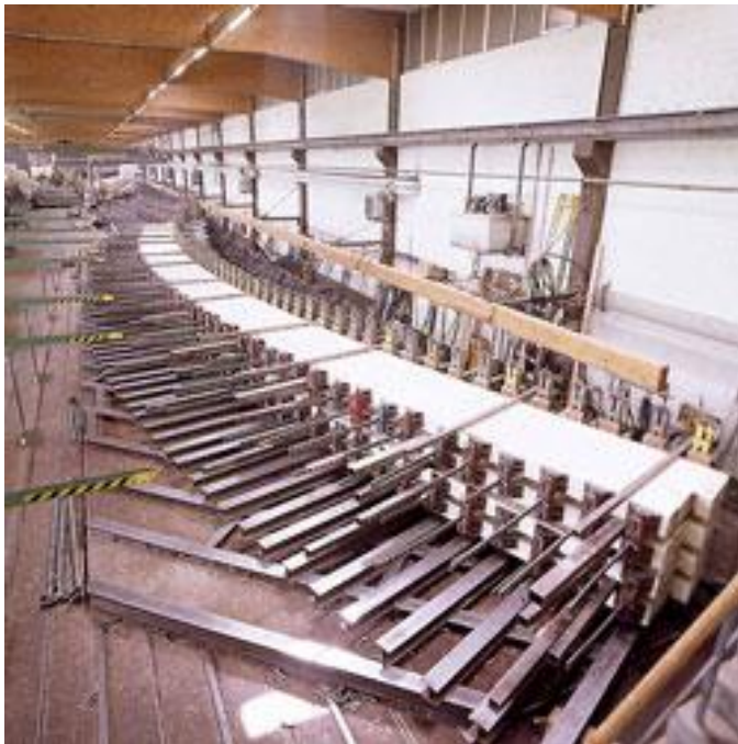
Bild 56: Verpressen der Lamellen in einem Pressbett [70]
