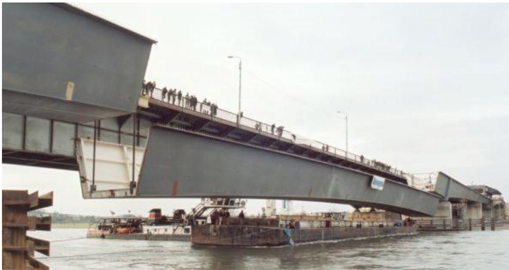
Bild 73: Einheben des Stahltrags einer Verbundbrücke [63]
