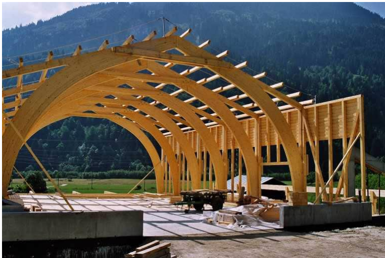
Bild 23: Brettschichthölzer als Tragwerk eines Gebäude [72]
