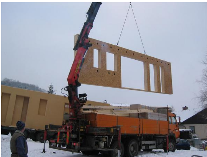
Bild 66: Errichtung eines Gebäudes in Tafelbauweise (Holzbau)
