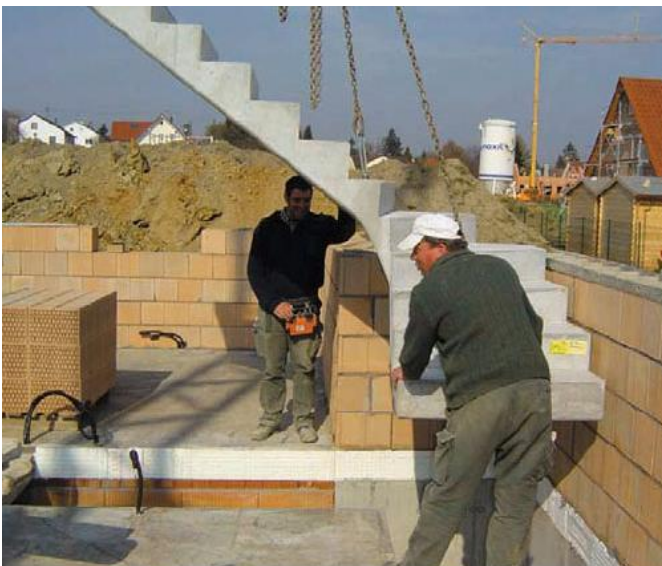
Bild 16: Fertigteil-Treppe beim Einbau [46]
