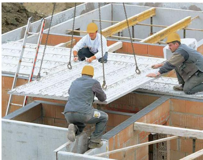
Bild 11: Verlegen einer Elementdeckenplatte [47]
