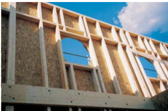
Bild 64: Wandbauteil in Rippenbauweise [71]
