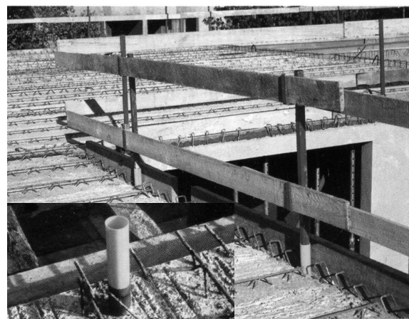
Bild 84: Montagehilfen für Absturzsicherungen im Fertigteilbau [66]
