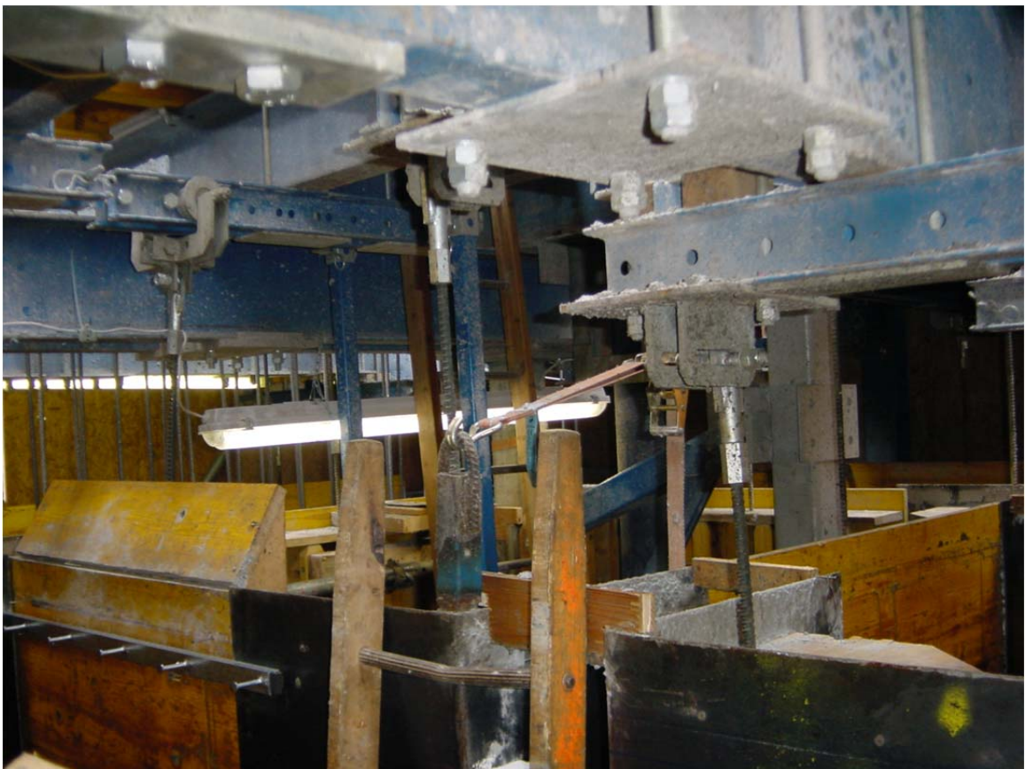
Bild 10-87: Abhängung der Wandschalungen
