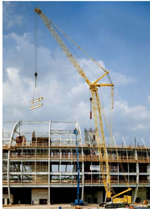
Bild 15-80: Montage mit einem Mobilkran [60]
