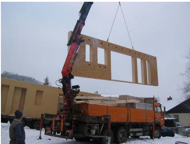
Bild 15-66: Errichtung eines Gebäudes in Tafelbauweise (Holzbau)
