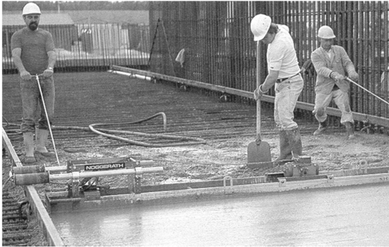
Bild 12-40: Betonflächenabziehvibrationsbohle [16]
