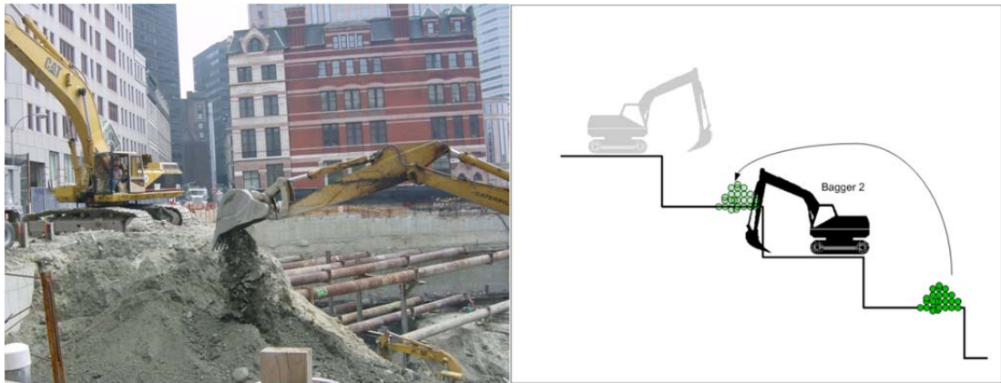
Bild 7-70: Zwischendeponieren des Aushubmaterials auf Stufe 3
