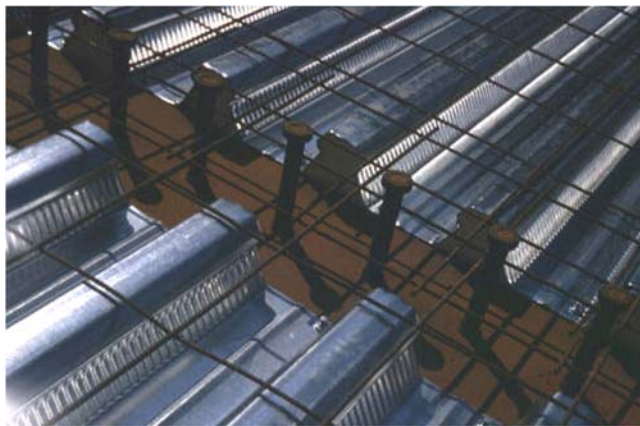
Bild 15-14: Stahlprofilblech-Verbunddecke [50] Die Kopfbolzendübel sind auf dem Unterzug (Verbundträger) aufgeschweisst.
