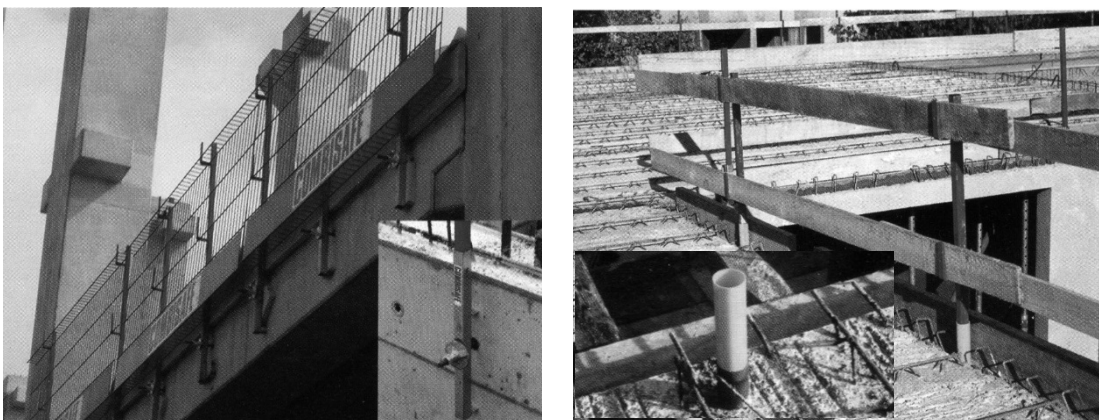
Bild 15-84: Montagehilfen für Absturzsicherungen im Fertigteilbau [66]
