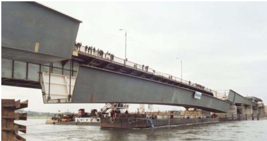
Bild 15-73: Einheben des Stahltrags einer Verbundbrücke [63]
