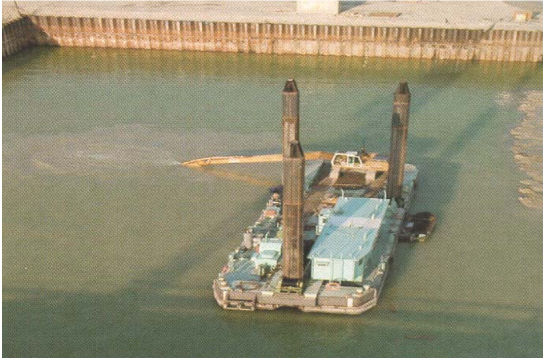
Bild 12-46: Unterwasseraushub und Planumserstellung vom Stelzenponton [18], S. 412
