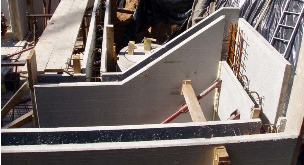
Bild 15-15: Hohl- oder Doppelwände mit Ortbetonausfüllung [48]
