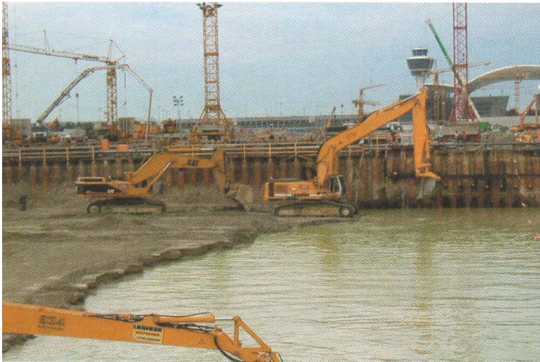
Bild 12-45: Unterwasseraushub vom Trockenabschnitt [18], S. 412
