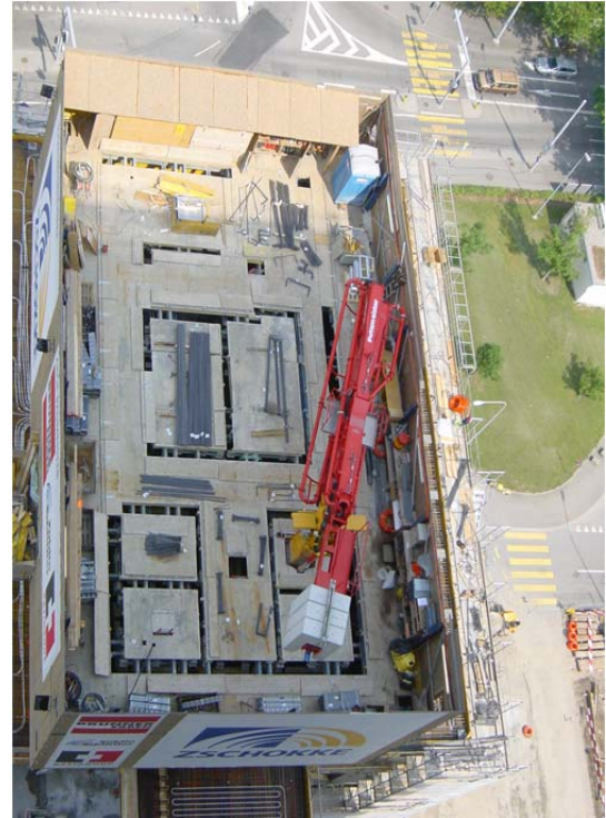
Bild 10-81: Selbstkletternde Schalungsplattform mit Einhausung und oberer Arbeitsplattform
