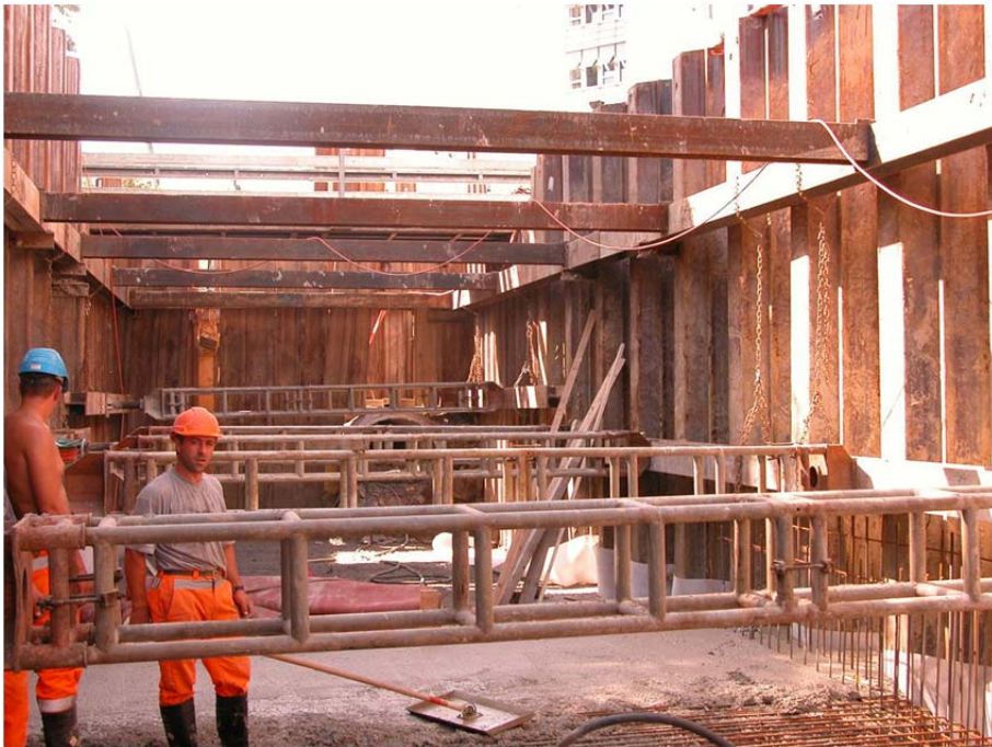
Bild 7-60: Grabenverbau mit Kanaldielen
