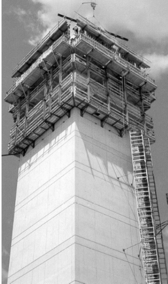
Bild 10-63: Kletterschalungssysteme [4]
