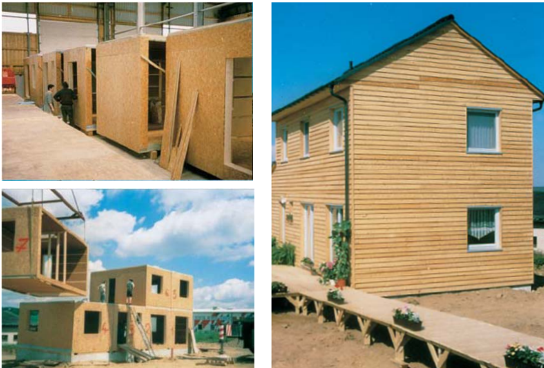
Bild 15-70: In Raumzellenbauweise errichtetes Gebäude [71]
