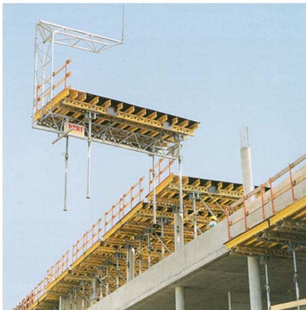
Bild 10-110: Umsetzen von Deckentischen mit krangeführtem Umsetzhaken („Entenschnabel“)[5]
