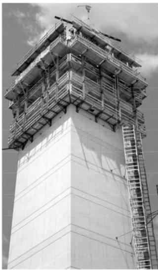
Bild 15-88: Selbstkletternde Schalung [82]
