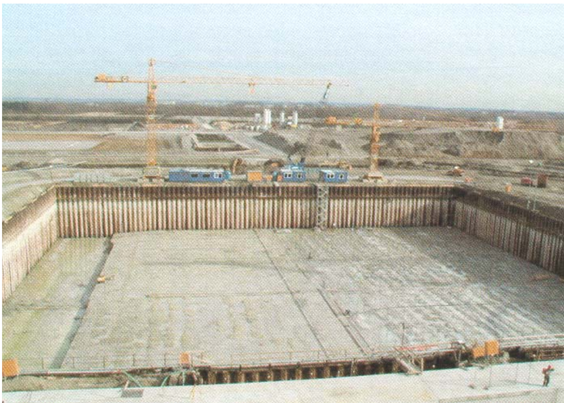
Bild 12-51: Gelenzte Baugrube [18], S. 414
