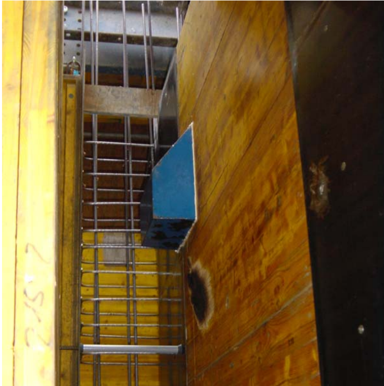
Bild 10-88: Einbauteil für Abstützaussparung
