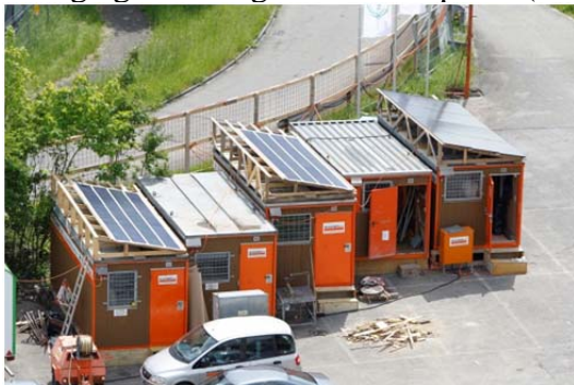
Bild 4-81: Solarpanel auf Baucontainer [Quelle: www.umweltarena.ch]
