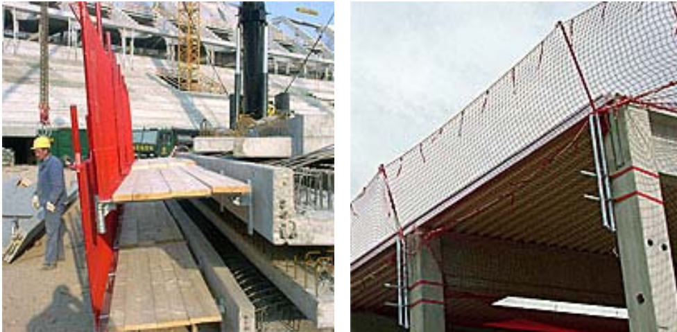
Bild 15-83: Absturzsicherung im Fertigteilbau [65]
