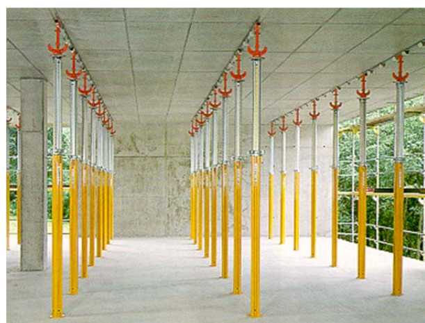
Bild 10-46: Fallkopfkassettenschalungssystem - Ausgeschaltetes System mit Hilfsabstützung [5]
