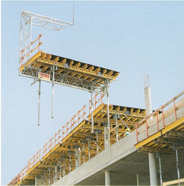
Bild 10-41: Umsetzen von Deckentischen mit krangeführtem Umsetzhaken („Entenschnabel“)[5]
