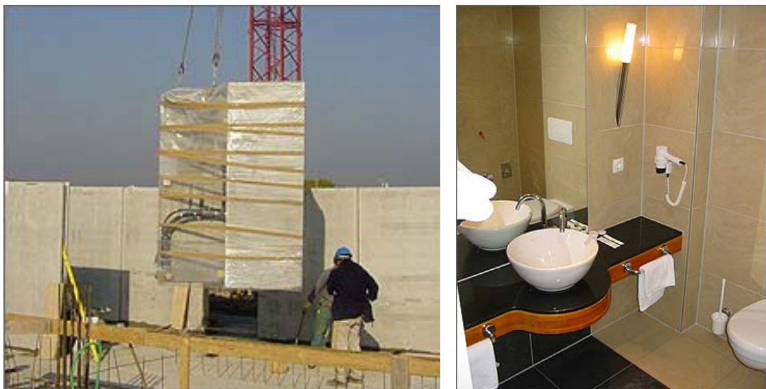
Bild 15-21: Kompaktes Fertigbad beim Einbau und Raumzelle von innen [44]
