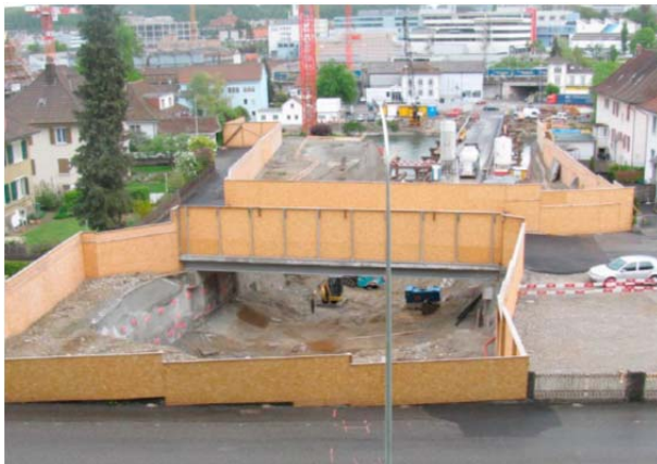
Bild 4-85: Lärm- und Staubschutzwand um den Voreinschnitt Ost beim Bau des Hausmatt-Tunnel in Olten [Quelle: Bau- und Justizdepartement des Kanton Solothurn]
