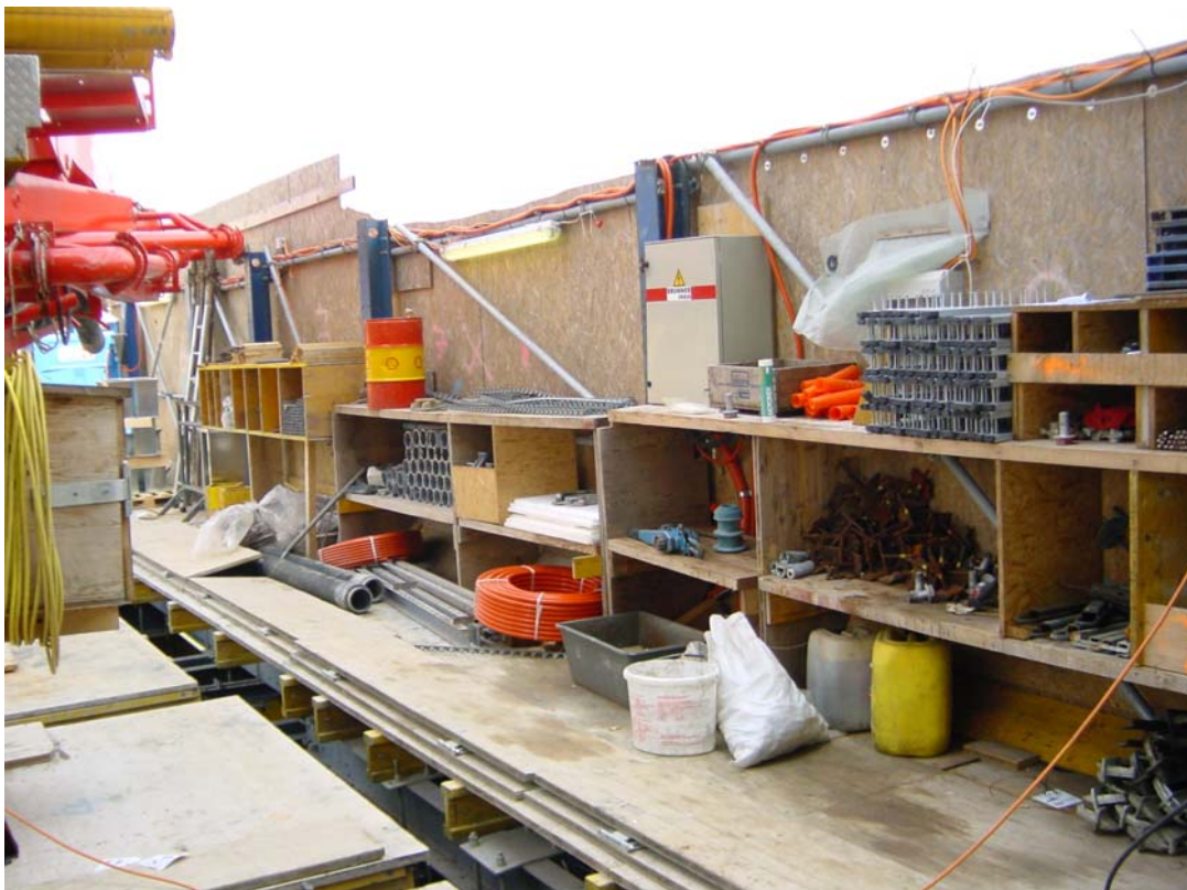
Bild 10-89: Obere Arbeitsplattform mit Materiallager
