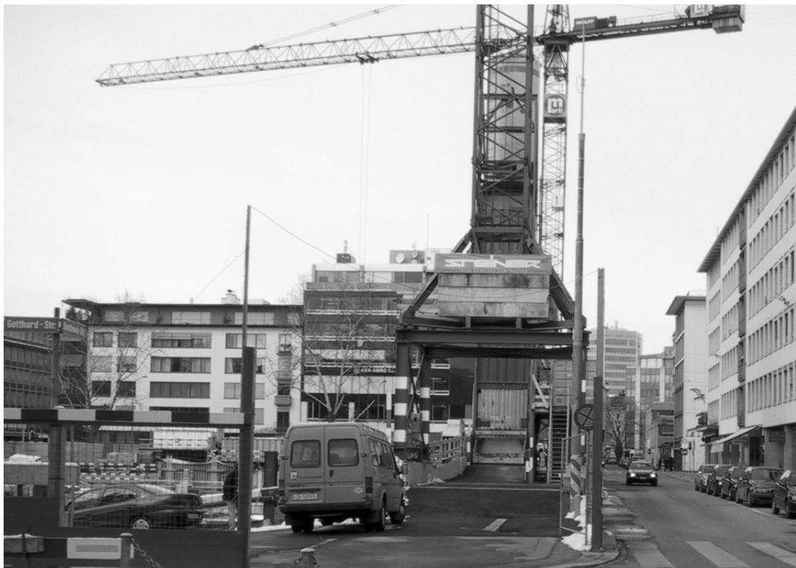
Bild 4-62: Innerstädtische Baustelleneinrichtung Kraaufstellung
