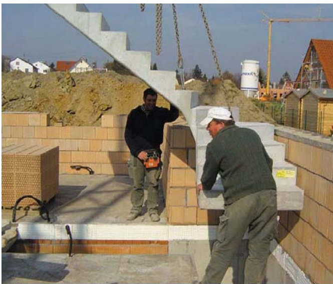
Bild 15-16: Fertigteil-Treppe beim Einbau [46]
