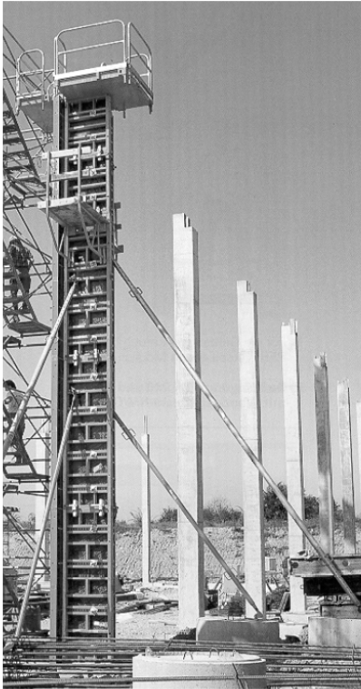
Bild 10-30: Modul-Stützenschalungen aus Rahmentafeln [6]
