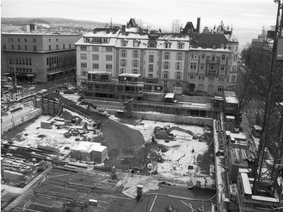
Bild 4-63: Innerstädtische Baustelleneinrichtung: Blick in die Baugrube
