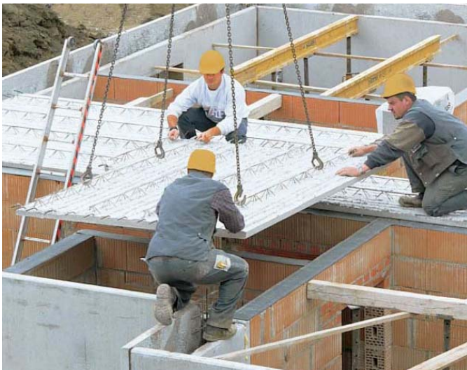
Bild 15-11: Verlegen einer Elementdeckenplatte [47]
