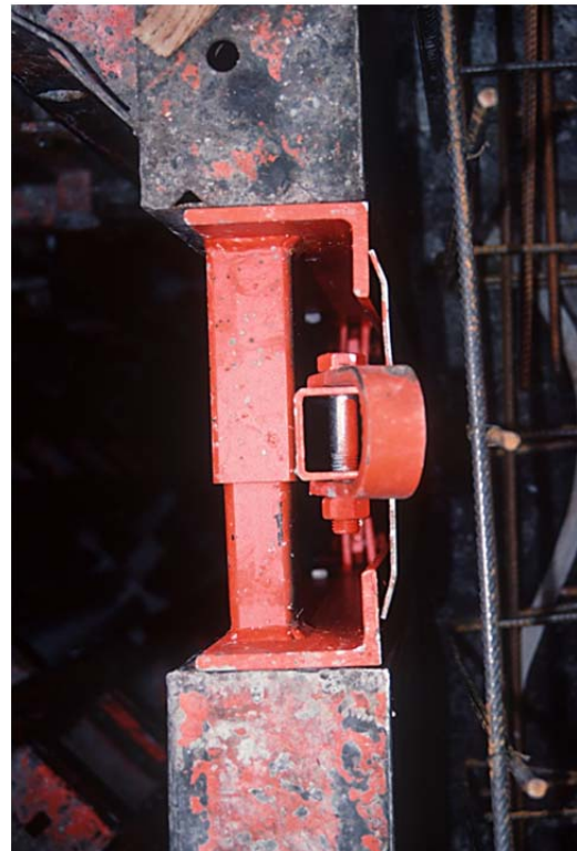
Bild 10-75: Draufsicht Ausschalschere
