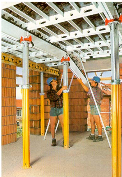
Bild 10-45: Fallkopfkassettenschalungssystem – Einschaltvorgang [5]
