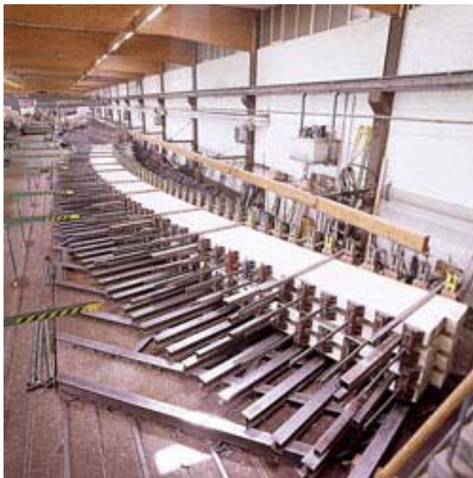
Bild 15-56: Verpressen der Lamellen in einem Pressbett [70]
