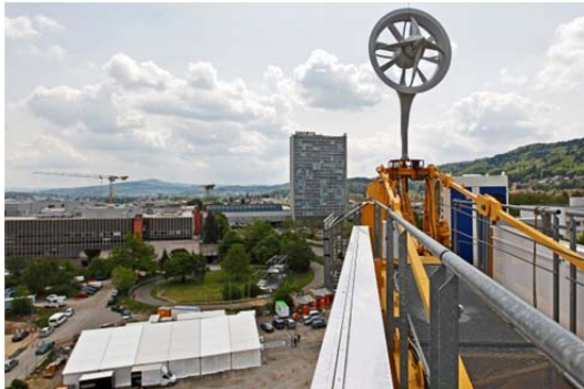
Bild 4-82: Windrad auf Baukran [Quelle: www.umweltarena.ch]
