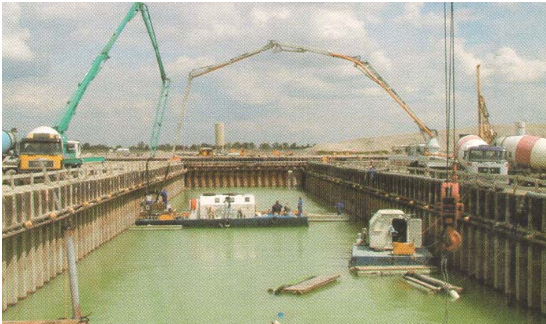
Bild 12-47: Einbau des UW-Betons vom Ponton mit Schablone für die Betonierrohrführung [18], S. 413
