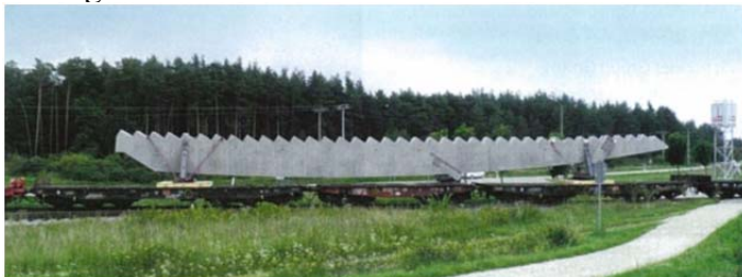
Bild 4-89: Versand eines Trägers via Bahn [Quelle: [21]]
