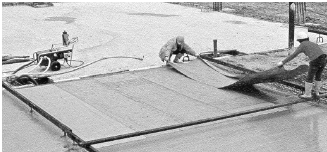
Bild 12-43: Auslegen von Vakuum-Filtermatten [17]
