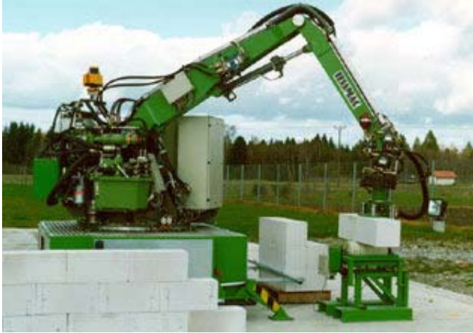
Bild 15-95: Mauwerkroboter für den Einsatz auf der Baustelle [10]
