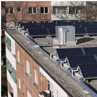
Bild 4-94: Solaranlage für die Warmwasseraufbereitung [Quelle: www.schweizer-metallbau.ch ]
