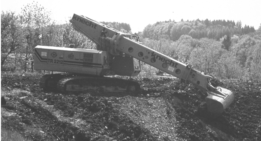
Bild 7-25: Teleskopbagger bei der Herstellung eines Böschungsplanums
