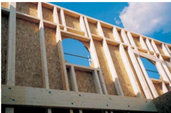
Bild 15-64: Wandbauteil in Rippenbauweise [71]
