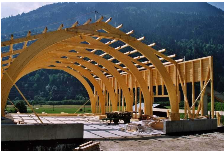
Bild 15-23: Brettschichthölzer als Tragwerk eines Gebäude [72]
