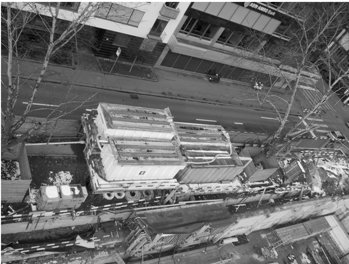
Bild 4-64: Innerstädtische Baustelleneinrichtung: Bentonitaufbereitung
