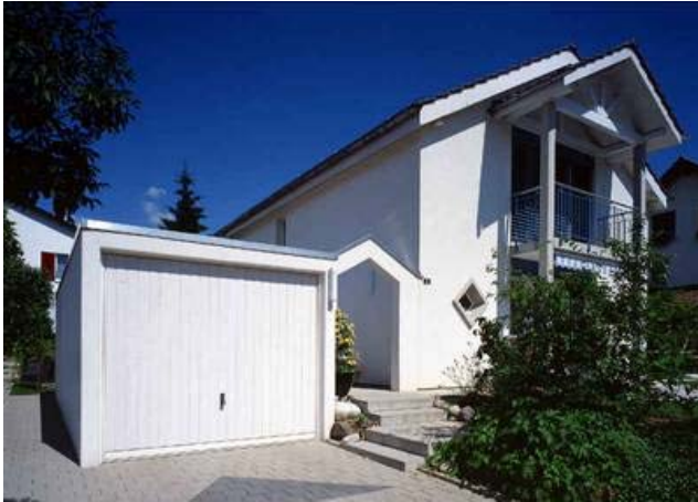
Bild 15-22: Fertigteilgarage als Anbau an bestehendes Gebäude [45]
