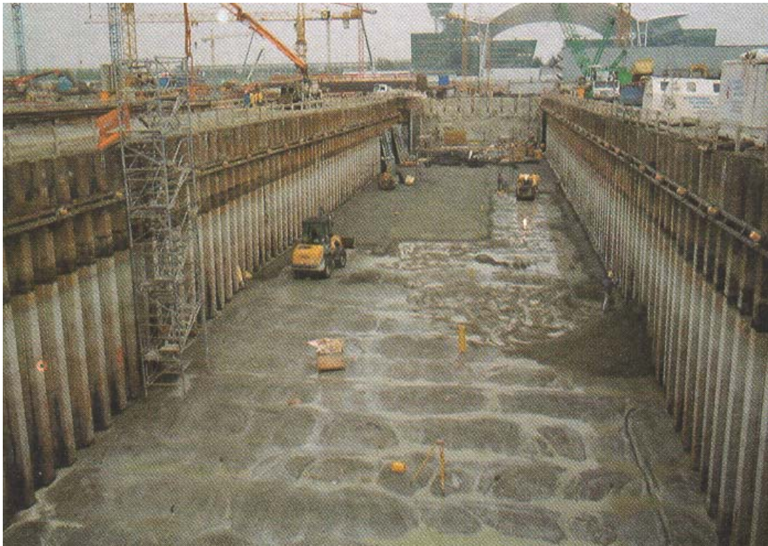
Bild 12-52: Gereinigte Baugrube [18], S. 414
