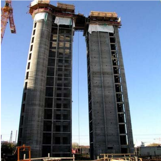
Bild 15-87: Im Gleitschalungsverfahren errichtete Treppen/Aufzugskerne [49]
