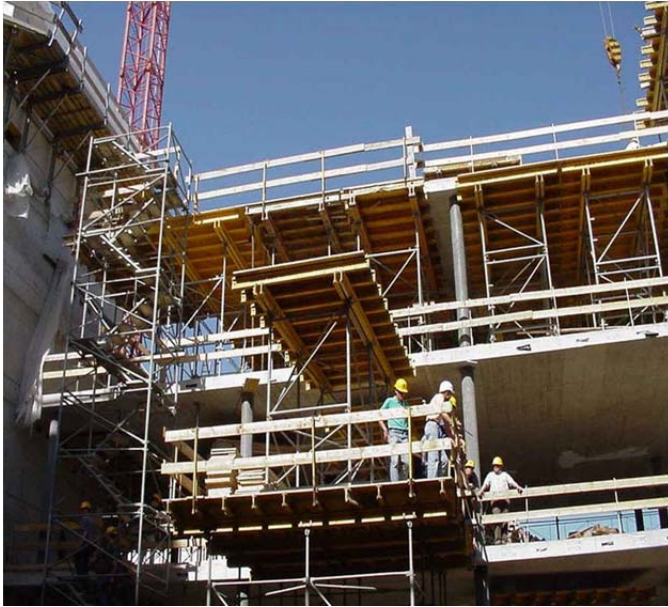
Bild 10-111: Umsetzen von Deckentischen mit nachgeführter Umsetzbühne
