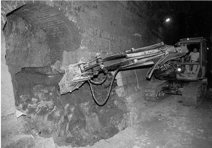
Bild 5-1: Nischenausbruch
