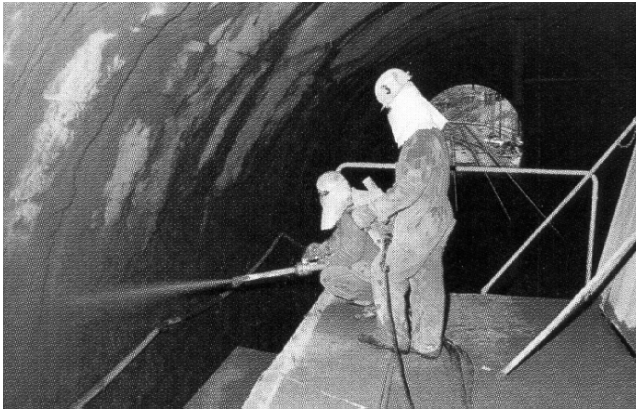
Bild 8-10: Einspritzen von Halbschalen
