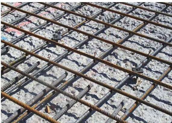
Bild 4–3: Zusätzliche Bewehrung
