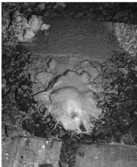
Bild 3-2: Schotterverschlämmung
