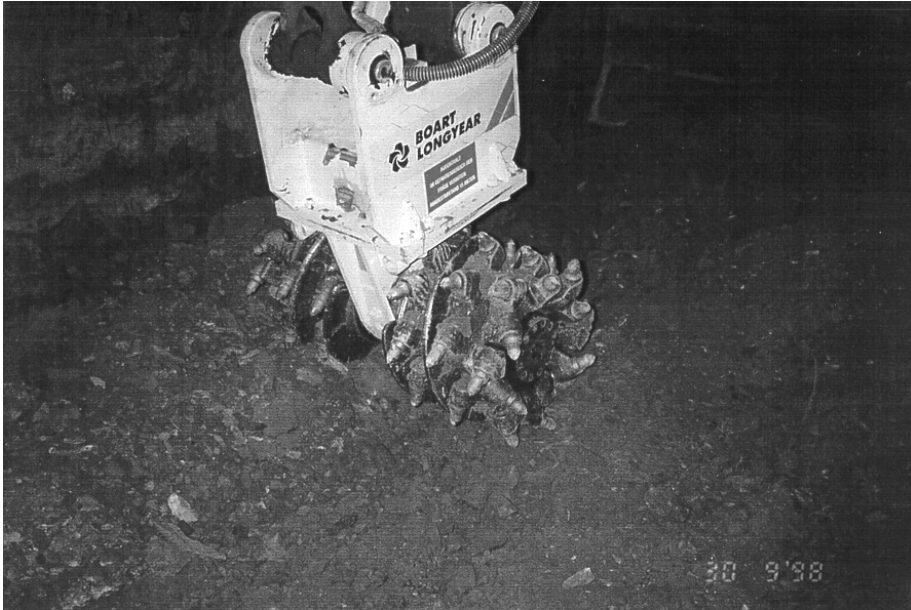
Bild 7-5: Sohlausbruch mit einer TSM auf einem Hydraulikbagger
