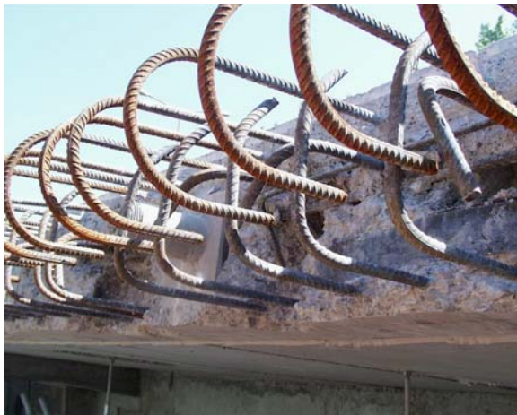
Bild 4–12: freigelegte Anschlussbewehrung
