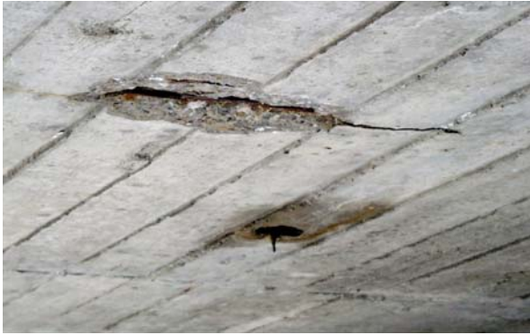
Bild 3–2: Abplatzungen an Brückenuntersicht
