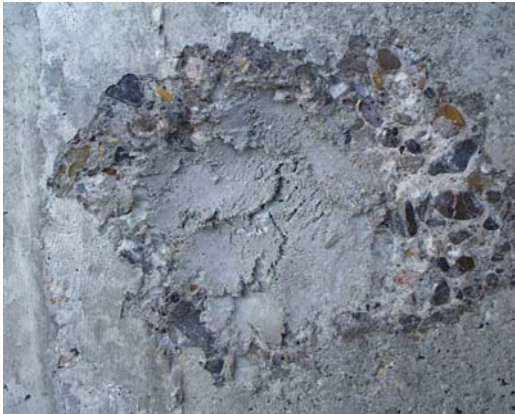
Bild 4–3: ungenügende Reprofilierung
