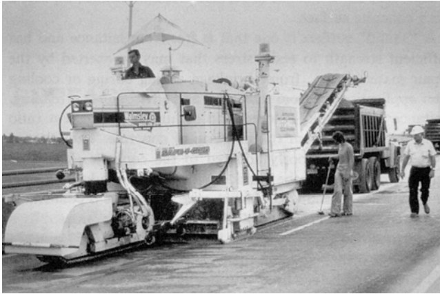
Bild 3-3: Fräsmaschine im Einsatz [4]
