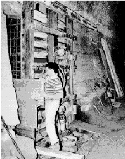
Bild 6-10: Schalungsarbeiten am Widerlager
