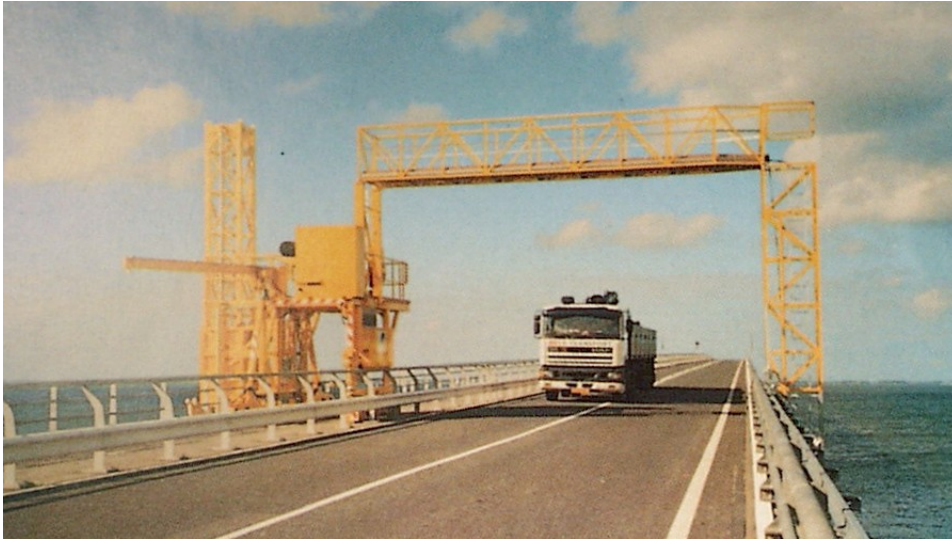
Bild 29: Installiertes mobiles Portalbrückengerüst
