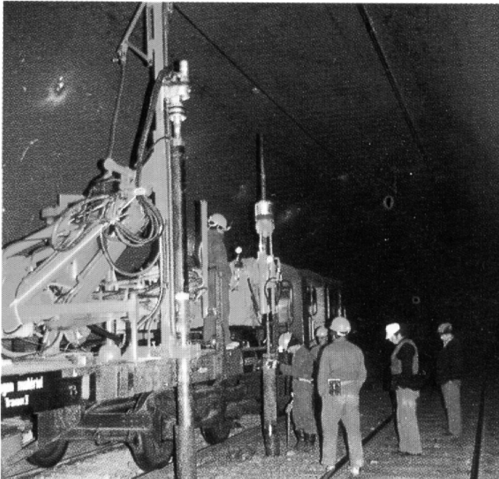
Bild 7-3: Bohr- und Versetzwagen für Rühlwandträger [33]
