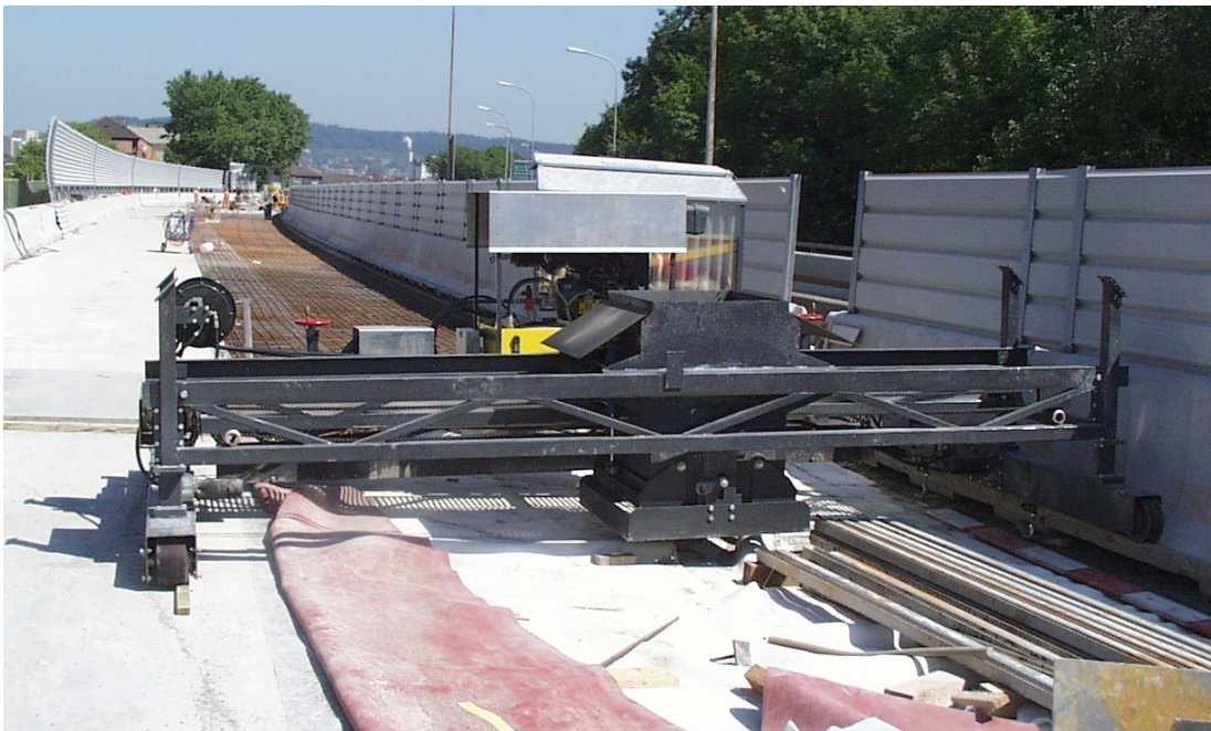
Bild 4–13: Fertiger zum Betonieren der Fahrbahnplatte
