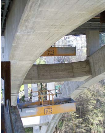
Bild 4–7: Hebebühnen
