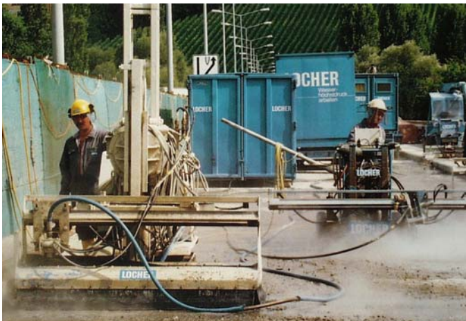
Bild 3–12: Maschineller Höchstdruckwasser-Abtrag
