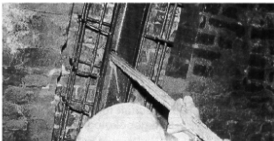
Bild 8-12: Stützrippen mit rückverankerten Stahlbögen
