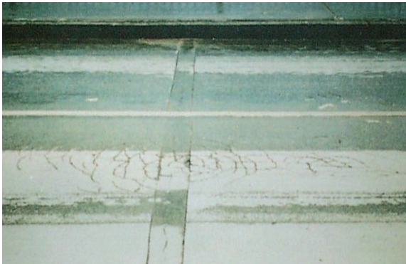
Bild 3-8: Fahrbahnrisse
