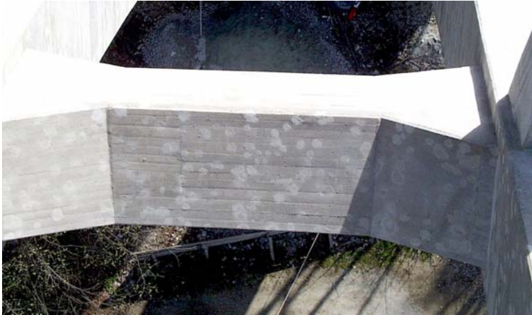
Bild 4–12: kleine Flickstellen an Brückenrahmen
