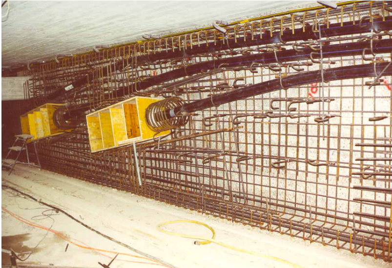
Bild 4-17: Endverankerung mit Stegvorbetonierung
