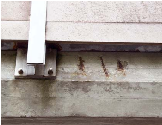
Bild 3–3: Abplatzungen an geschützten Konsolköpfen
