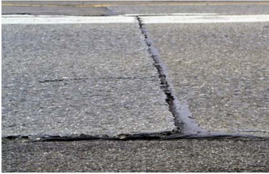
Bild 3-7: Risse und ungenügende Fugen in Fahrbahn
