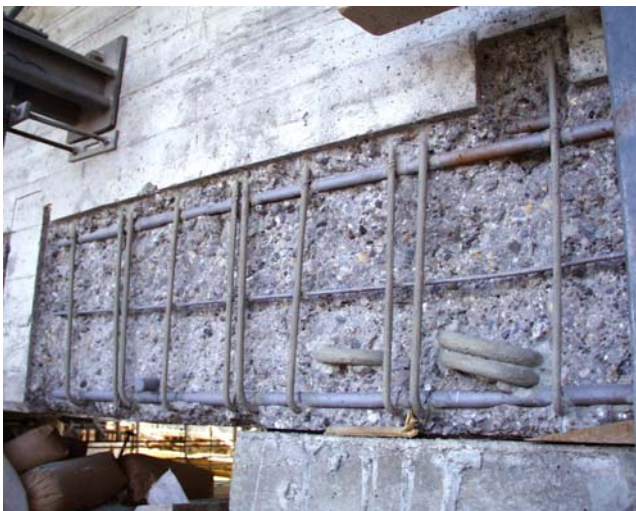
Bild 4–1: Ausbruchstelle mit behandelten und unbehandelten Eisen
