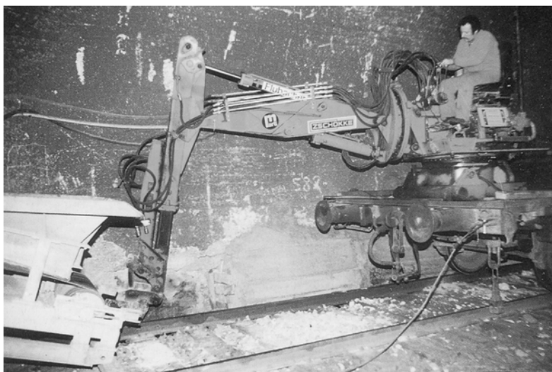
Bild 6-8: Spezialbagger mit horizontal drehbarem Ausleger für Widerlagerausbruch und -aushub [34]
