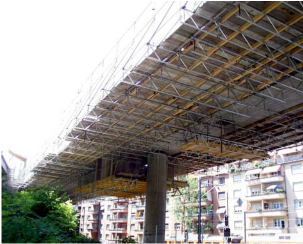
Bild 4–9: Abfahrtsrampe im innerstädtischen Bereich
