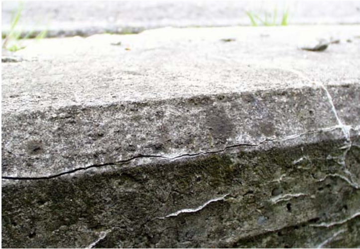
Bild 3–5: Riss mit Aussinterungen an Konsolkopf
