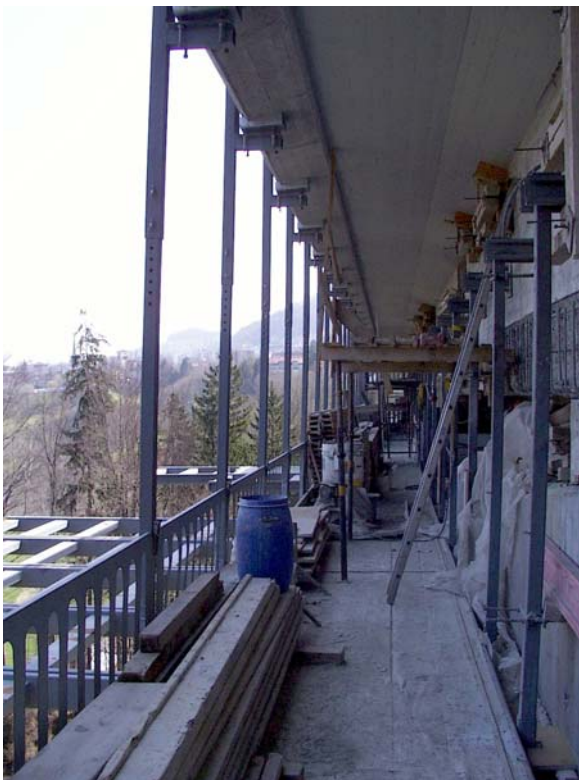
Bild 4–6: Arbeitsplattform
