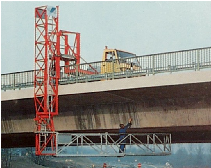
Bild 32: Mobile Inspektions- und Arbeitsplattformen auf LKW-Träger
