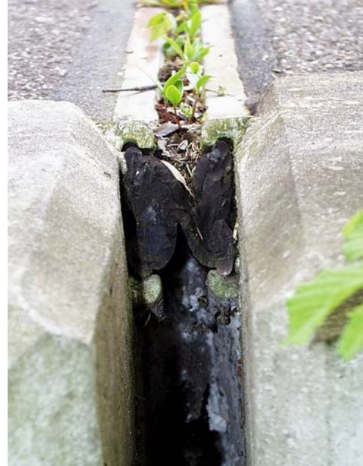
Bild 3-9: Fugendetail bewachsen
