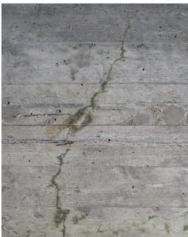
Bild 3–4: wasserführender Riss
