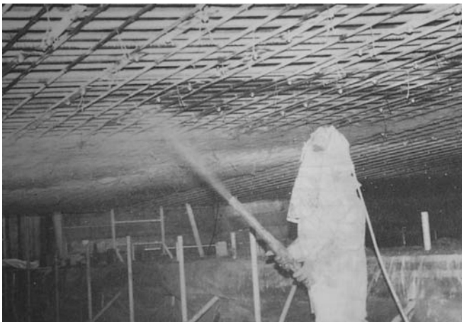
Bild 5–3: Spritzbetoneintrag Überkopf
