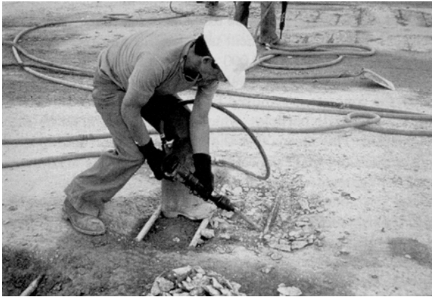
Bild 3–2: Betonabbruch mit Spitzhammer [11]
