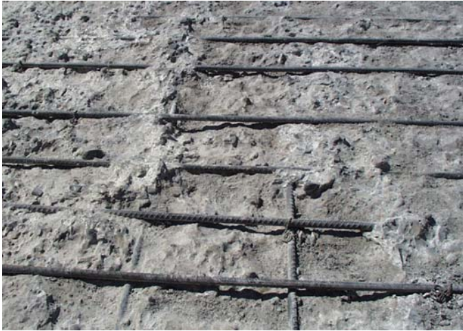
Bild 3–11: Mit Höchstdruckwasser behandelte Betonoberfläche
