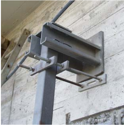
Bild 4–5: Gerüstbefestigung
