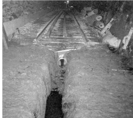
Bild 7-8: Entwässerungsgraben mit Grabenfräse erstellt [36]
