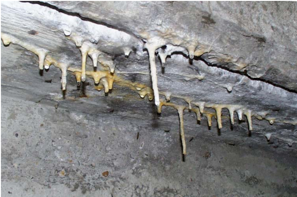
Bild 3–6: Aussinterungen an Brückenunterseite
