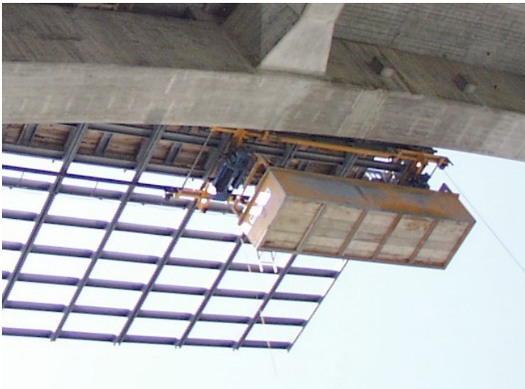
Bild 4–8: Befestigung der Hebebühne am Rahmen
