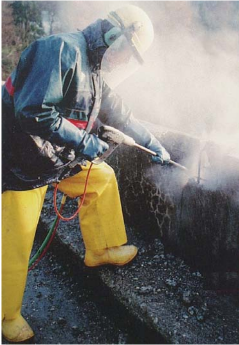
Bild 3–13: Höchstdruckwasser-Abtrag mit Handlanze
