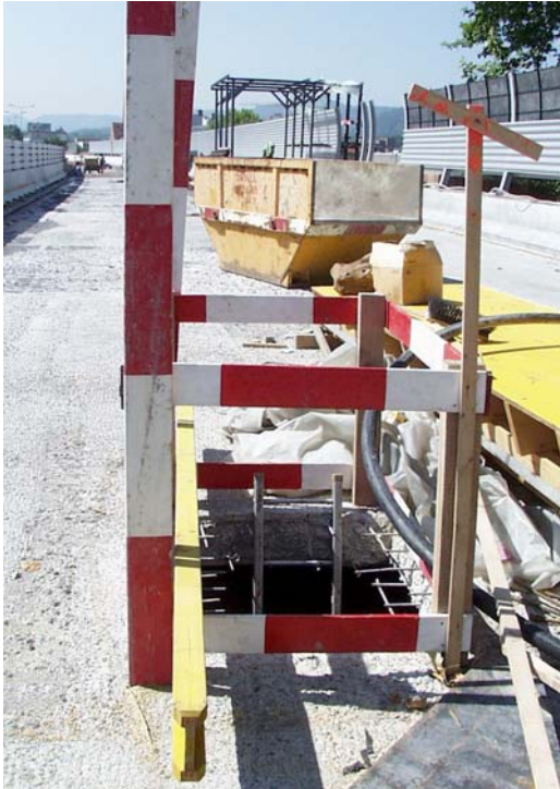
Bild 4–14: Einstieg in Hohlkasten
