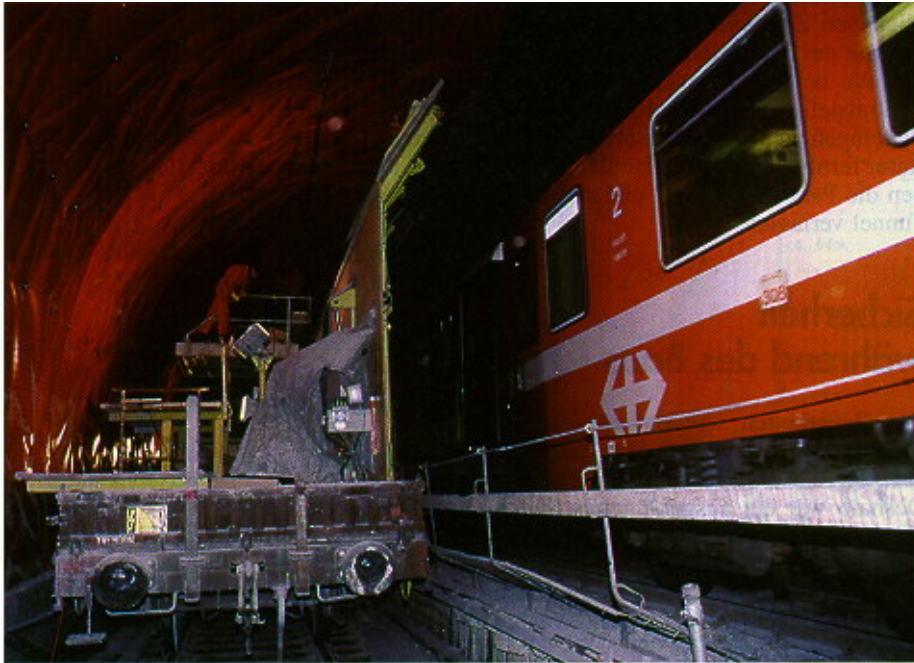
Bild 7-4: Bauzug mit Schutzwand [33]
