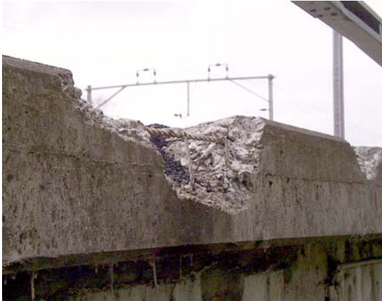
Bild 3-13: Abplatzungen durch Unfall
