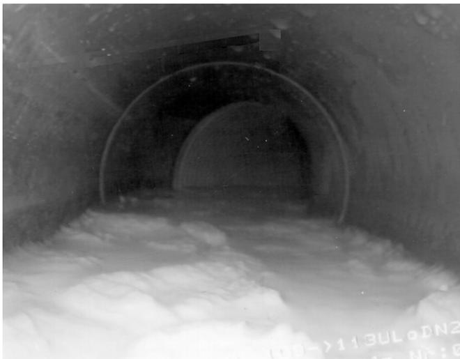
Bild 1. Versinterung im Drainagerohr vor der Reinigung
