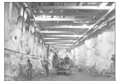
Bild 16. Unterhalb der aufgehängten Plattform: Sohlausbau und Sohleinbau [12] Fig. 16. Underneath the suspended platform: base excavation and base construction [12]
