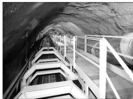
Bild 15. Auf der aufgehängten Plattform: Förderband, Lutte und Fussweg [12] Fig. 15. On top of the suspended platform: conveyor belt, air duct and walkway [12]
