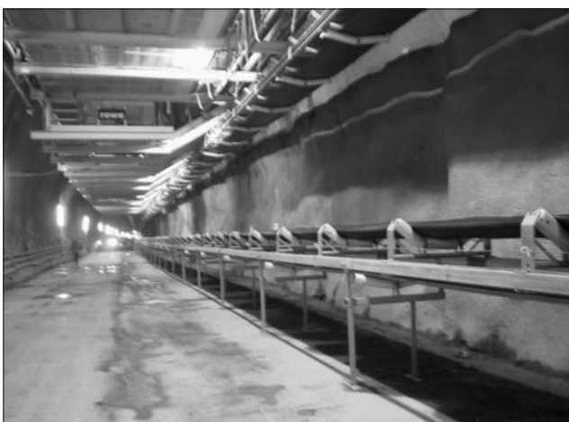
Bild 19. Unterhalb der aufgehängten Plattform: Ladezone mit Ausbruchtransfer vom Plattformförderband auf das Streckenförderband [12] Fig. 19. Underneath the suspended platform: loading area with muck transfer from platform conveyor to the tunnel conveyor belt [12]
