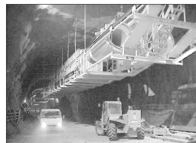
Bild 20. Rückseite der aufgehängten Plattform: Luftspeicher und Magazincontainer sowie sonstige Hilfsinfrastruktur [12] Fig. 20. Rear view of the suspended platform: air duct storage and magazine container as well as other support infrastructure [12]
