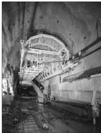
Bild 14. Trümmerschutz - Brecher - schräges Zuführungsband [12] Fig. 14. Rock debris protection - crusher - inclined feeding belt [12]
