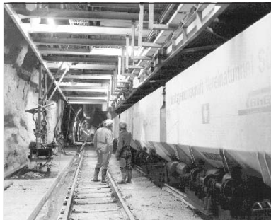
Bild 18. Unterhalb der aufgehängten Plattform: Ladezone mit Ausbruchtransfer vom Plattformförderband auf den Schutterzug [12] Fig. 18. Underneath the suspended platform: loading area with muck transfer from platform conveyor to the muck train [12]
